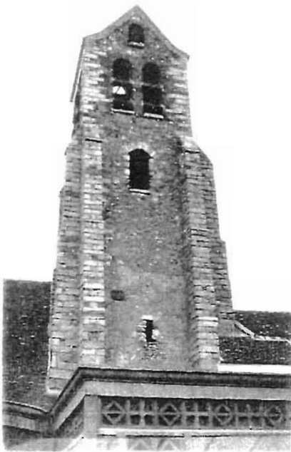
1927 - Sous le clocher, les agrandissements de béton.
